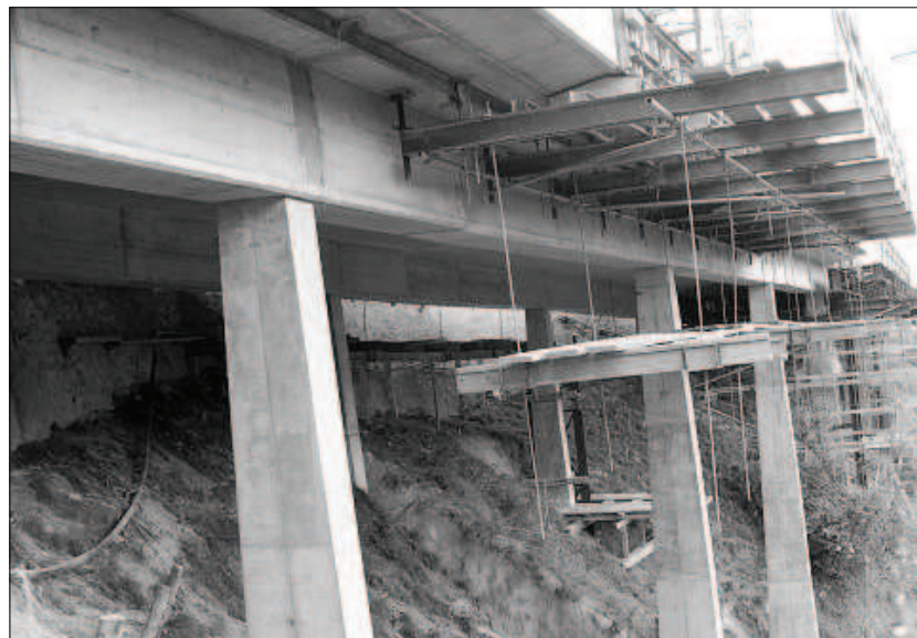
La construcziun dalla via denter Garmischeras e Tschepa s'avanza sco previu.
